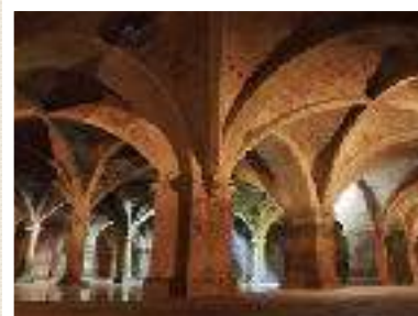
EL JADIDA CISTERN
